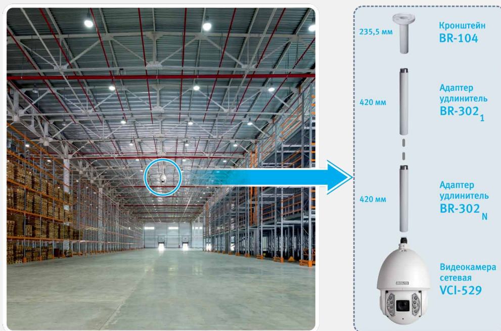
Рисунок 70. Пример монтажа поворотной камеры с помощью адаптеров-удлинителей
